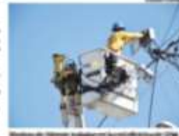
Trabajador de Edeeste instala un moderno transformador de 50 MVA.
